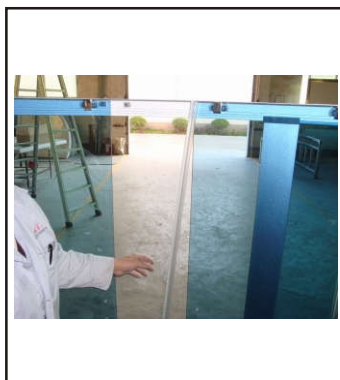
25. Montera magnetlisterna på glasdörrarna
