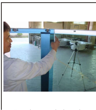
24. Fäst listen till glasdörren så att den tätar mot aluminiumprofilen
