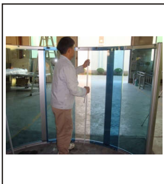
25. Montera magnetlisterna på glasdörrarna
