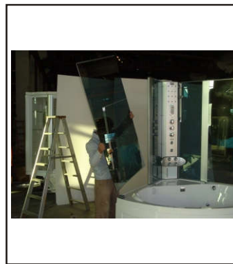
17. Installera glas vänster sida
