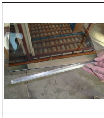
4. Installera den H-Formade listen till alla glassidor
