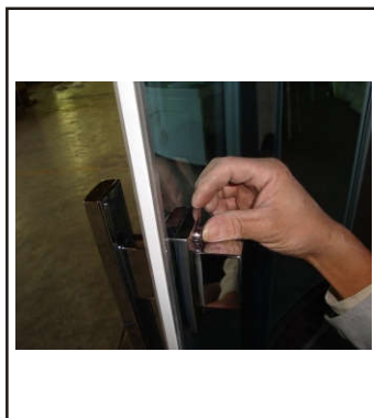
25. Montera magnetlisterna på glasdörrarna
