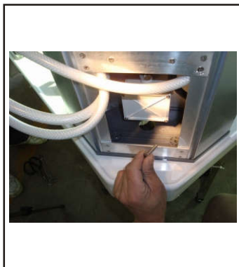
7. Fäst duschpanelen i position med skruvar och muttrar (M6x25)
