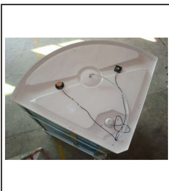
32. Koppla till ledning för lampa, högtalare och ventilation
