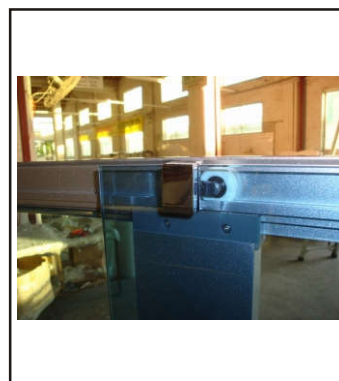
22. Montera på hjulen till glasdörren
