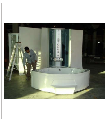
14. Installera glas på vänstra sidan samt aluminiumramen
