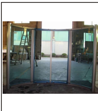
24. Fäst listen till glasdörren så att den tätar mot aluminiumprofilen
