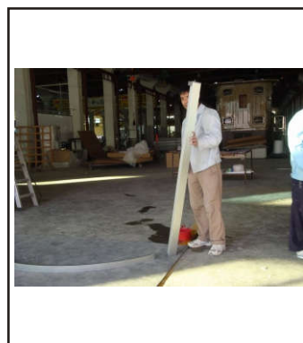
18. Installera Aluminiumramen till glassörren
