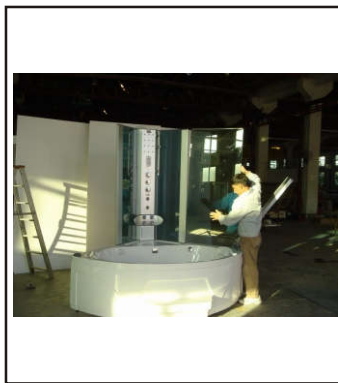
14. Installera glas på vänstra sidan samt aluminiumramen
