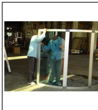
19. Installera glaset på sidan av glasdörren
